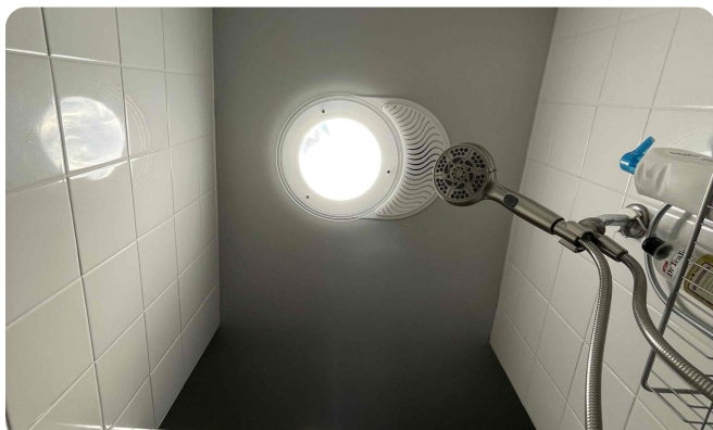
Izquierda: difusor con ventilación integrada en una ducha. Derecha: componentes del sistema — tubos, codos, bases y domo.
